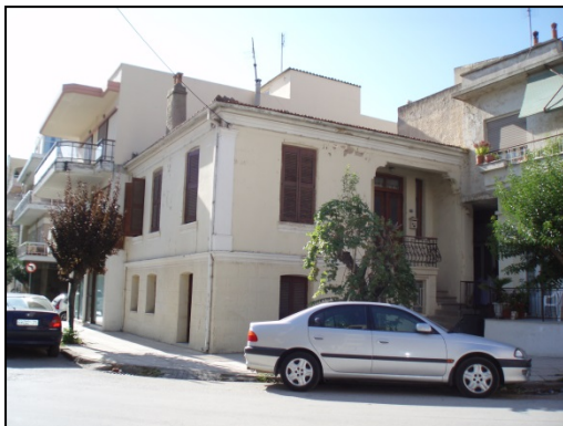
Διόροφη κατοικία στην συμβολή των οδών Εθν.Αντίστασης και Αίνου. Κατεδαφίσθηκε τον Φεβρουάριο του 2011.
