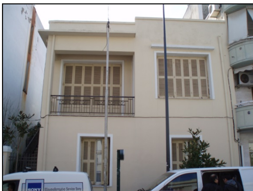
Διόροφο κτίσμα επί της οδού Ι.Καβύρη 13.
