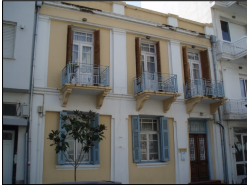
Διόροφο κτίσμα επί της οδού Ι.Καβύρη 43.
