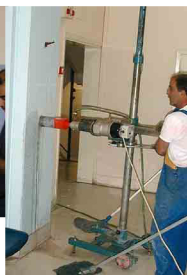
Πυρηνοληψίες σε υποστυλώματα με κατάλληλο περιστροφικό τρυπάνι με αδαμαντοκορόνα
