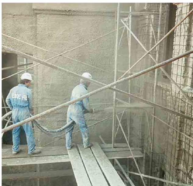
Χρήση εκτοξευόμενου σκυροδέματος
