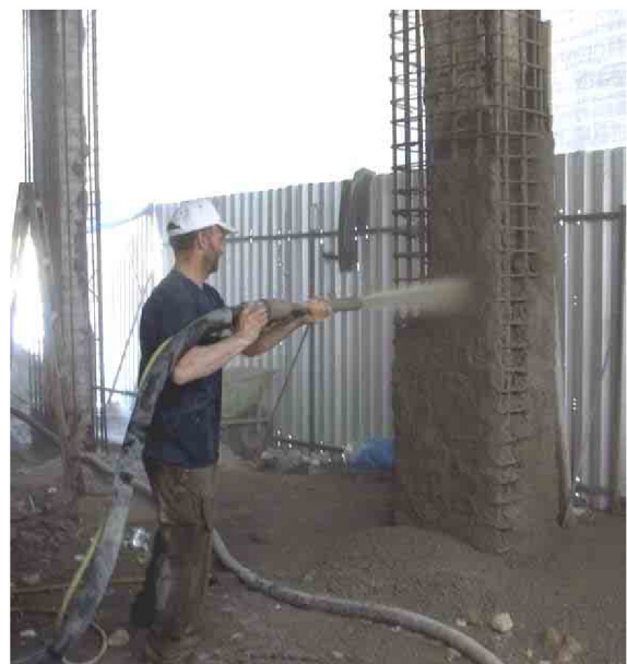
Χρήση εκτοξευόμενου σκυροδέματος
