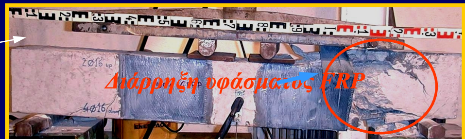
Δοκός RJm: Τα υφάσματα από FRP στα μεσαία τμήματα περιόρισαν την ανάπτυξη ρηγματώσεων.
